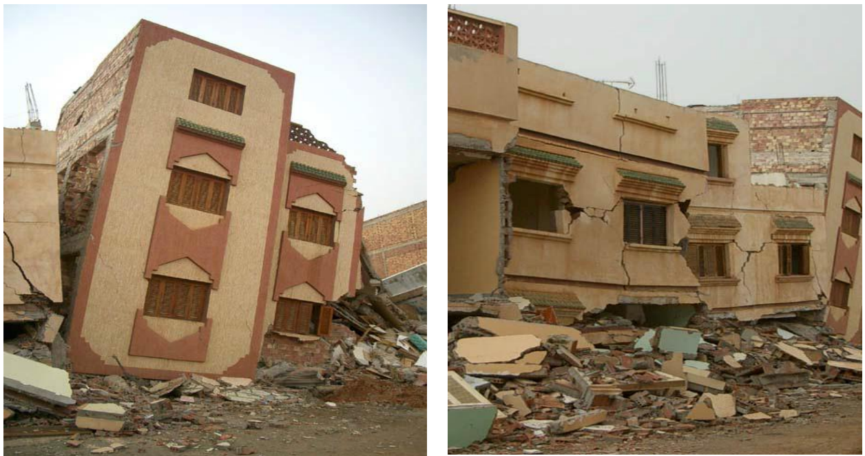
Figure 1 : la ville d'Imzouren après un séisme d'une magnitude de M_w = 6.2 le 24 février 2004
